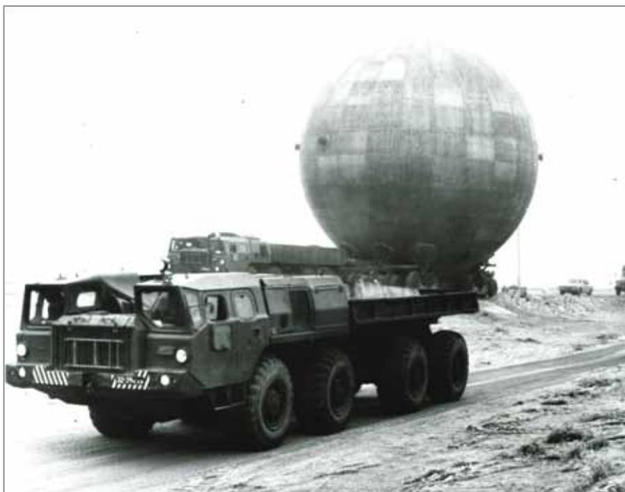
**Впервые в СССР перевозка полностью собранных в цеховых условиях (в МИКе) шаровых криогенных резервуаров  $V=1400 \text{ м}^3$  на специально доработанном трейлере**
